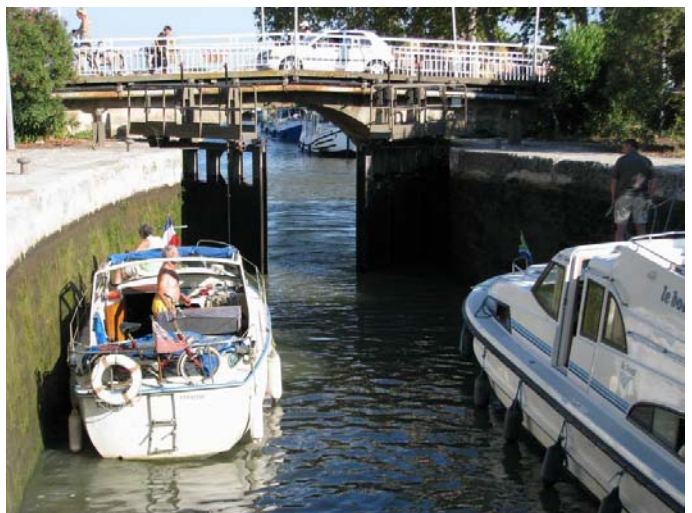
Canal du Midi - zapornice
