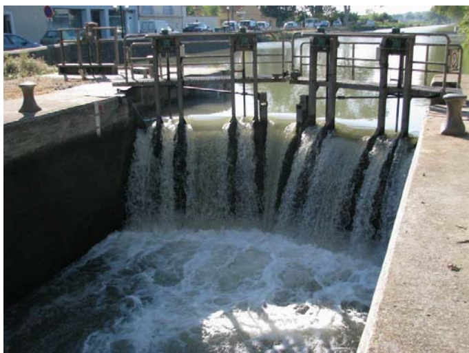
Canal du Midi – zapornice
